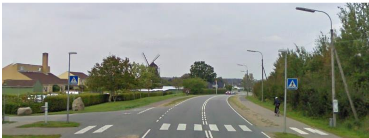
Figur 4 Fodgængerfelt ved Mølleparken. Bemærk at belysningen er renoveret.
